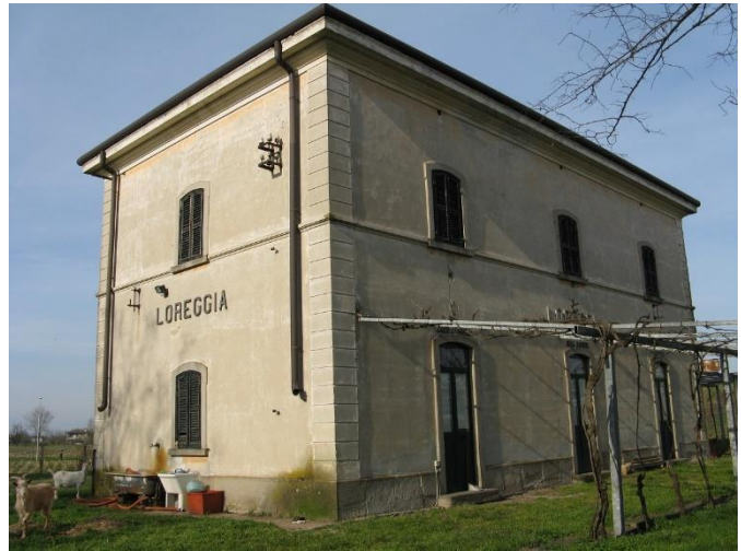
Fabbricato viaggiatori (stazione)
