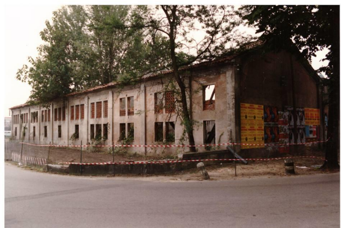
Deposito locomotive poco prima della demolizione
