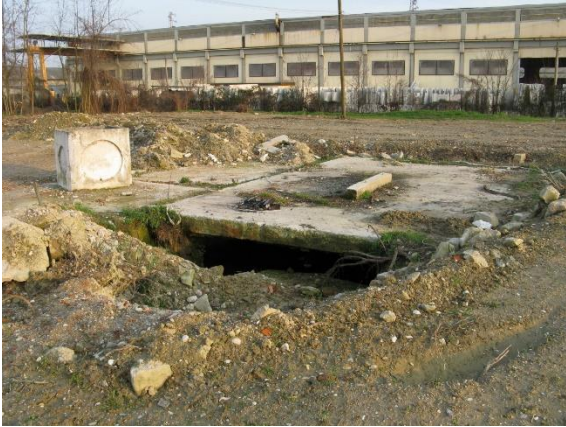
Resti del fabbricato viaggiatori (stazione) (2008)
