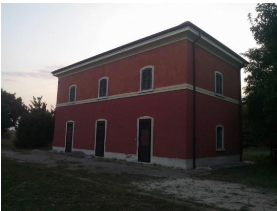
Fabbricato viaggiatori (stazione)
