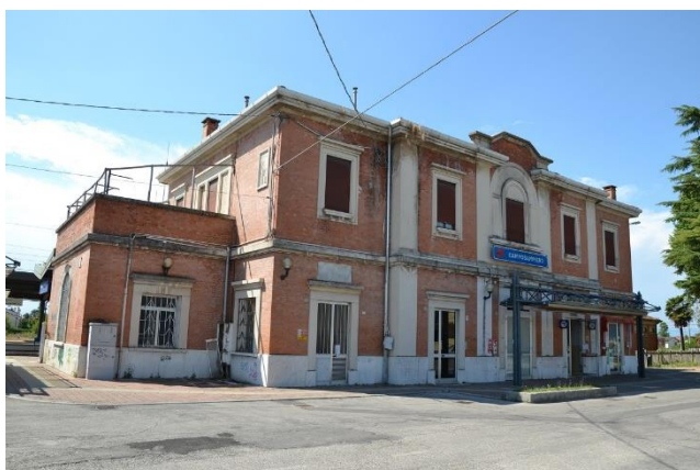
Fabbricato viaggiatori (stazione)
