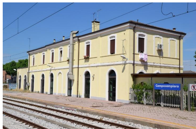
Fabbricato servizi sussidiari (vecchia stazione)
